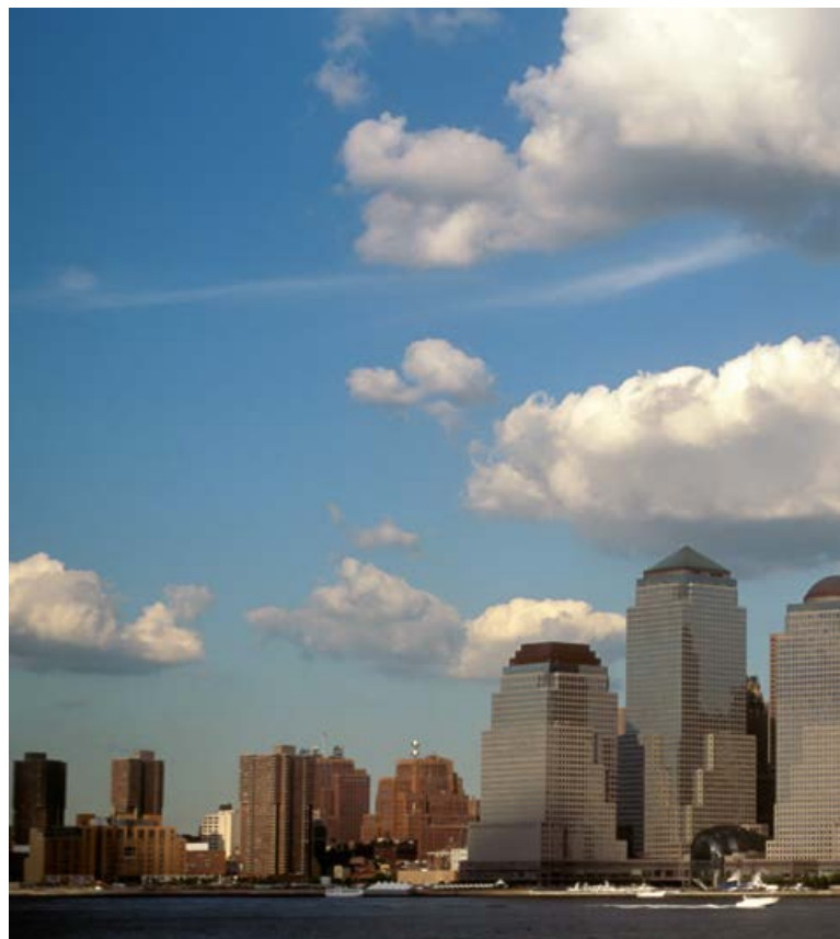
Das World Trade Center war ein siebenteiliger Gebäudekomplex in New York City; die beiden bekanntesten Gebäude waren die Zwillingstürme, welche 1970 und 1971 vollendet und 1973 offiziell eröffnet wurden.
